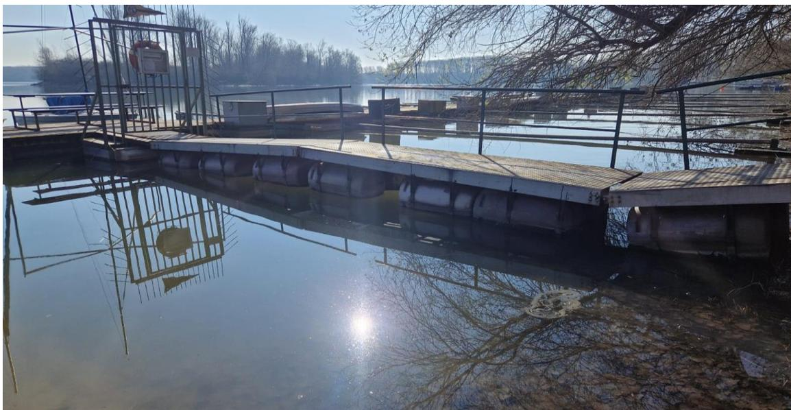
In 2023 wurden zugängliche Metallteile des Stags mit Hammerite gestrichen, 6 Holzelemente wurden ausgetauscht.
